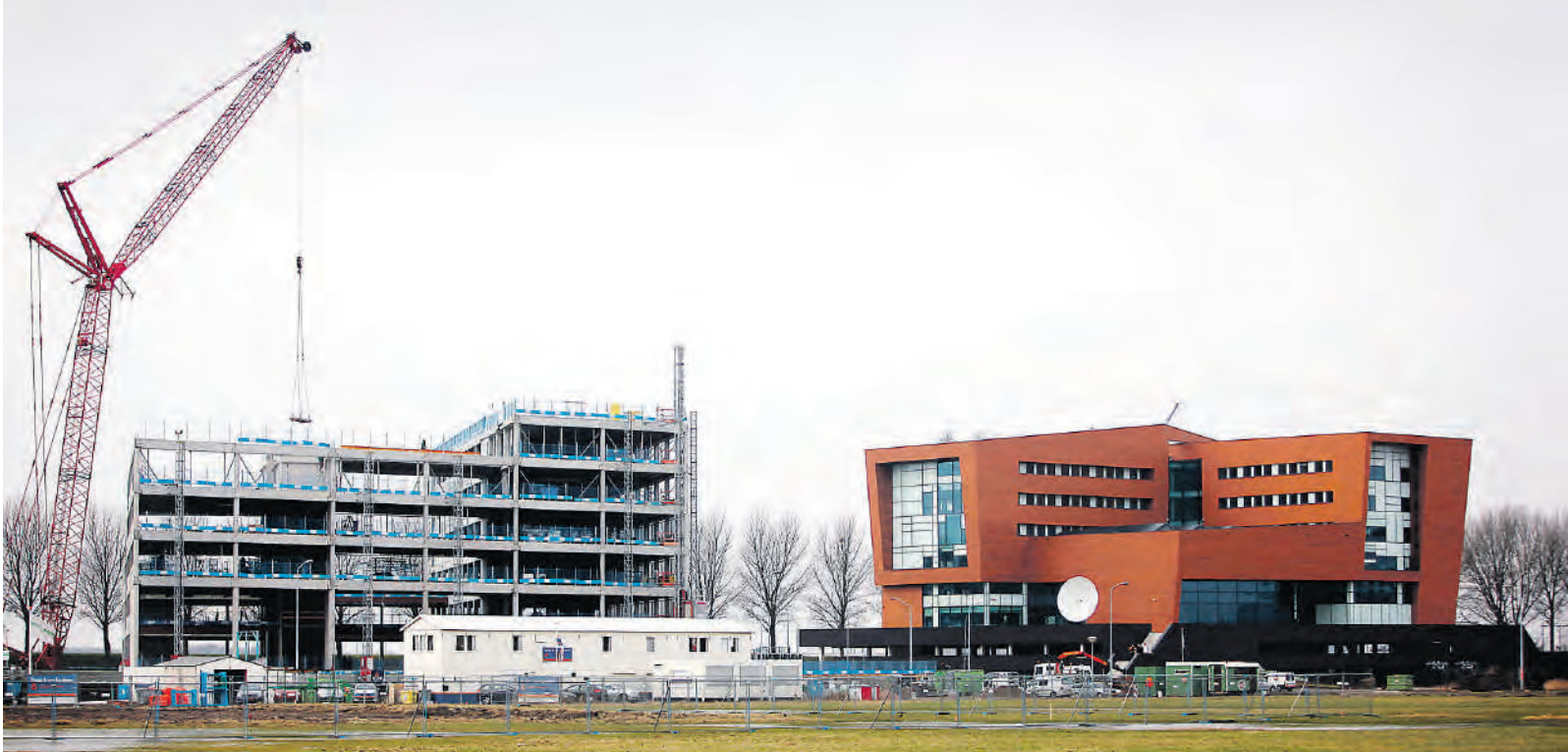
Links het kantoorpand van postbedrijf TNT in aanbouw in Hoofddorp : compact met veel daglicht.
