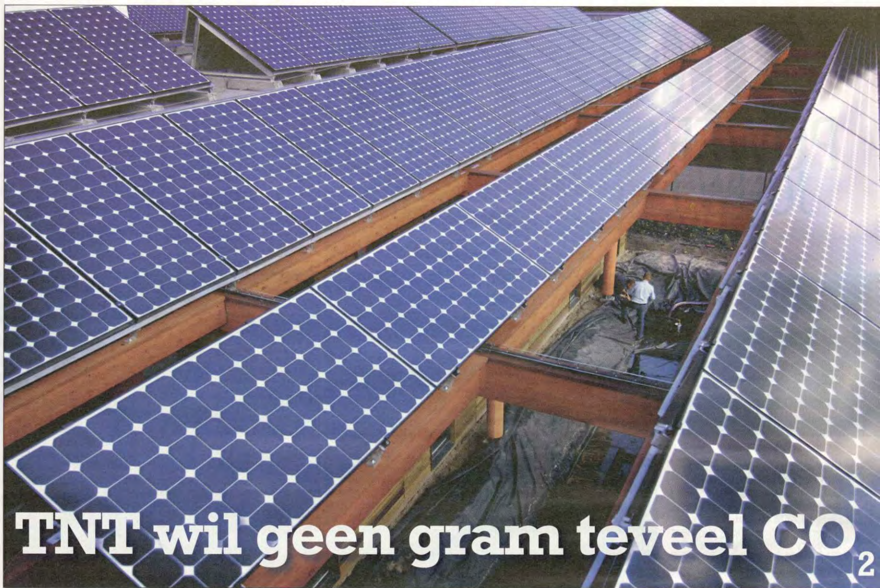
In Veenendaal heeft TNT een klein postsorteercentrum gebouwd dat volgens het bedrijf CO 2 -neutraal is. Met behulp van een warmte/koudeopslagsysteem en zonnepanelen op het dak produceert het 1200 m 2 grote gebouwje net zoveel warmte en energie als het nodig heeft
